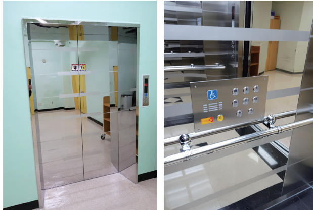
[그림 3-14] 인화물용 노후 엘리베이터 교체 후 사진
